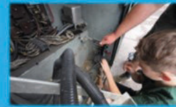
Reparatur Lüfter und Austausch Luftfilter
