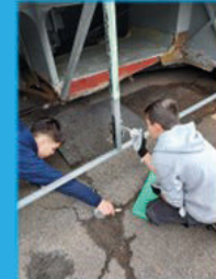
Lackieren der neu eingeschweißten Streben
