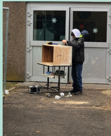
Lackentfernung mit dem Schleifgerät
